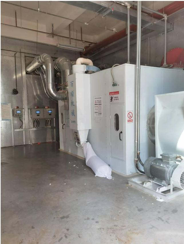
图 4-2 梳棉废气治理装置
