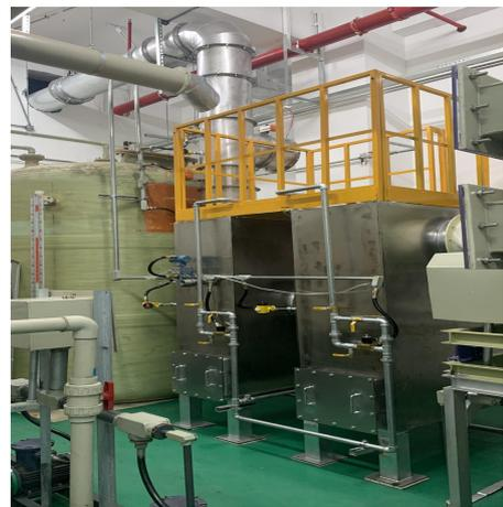
图 4-3 EOG 灭菌废气治理装置
