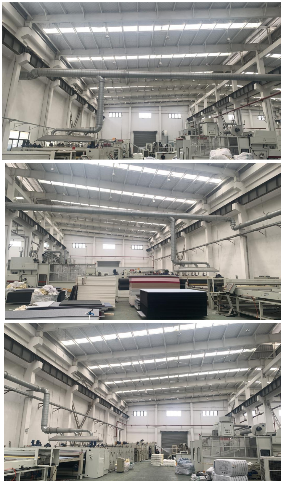
图 4-2 废气收集装置
