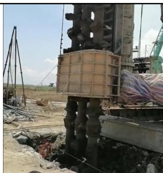
用于软土层地基/基坑及道路工程中的深层搅拌
