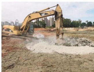
用于特殊土层的建筑地基、道路路基、浅层土工特性提升
