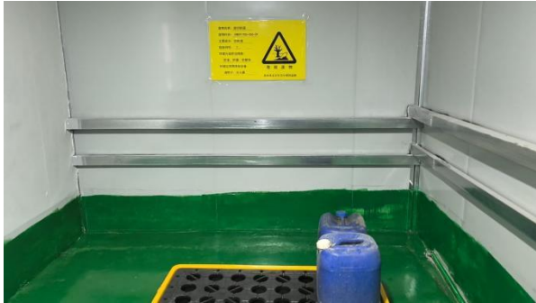
危险废物仓库
