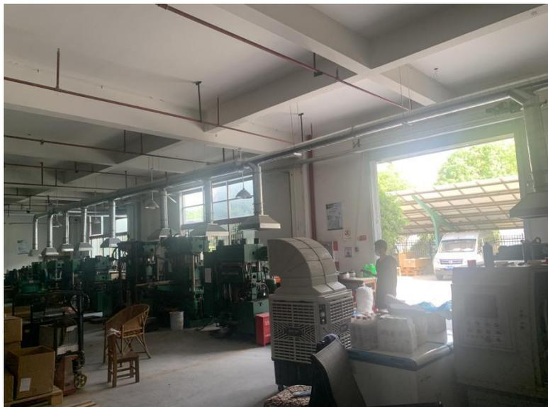
图 4-1 废气收集装置
