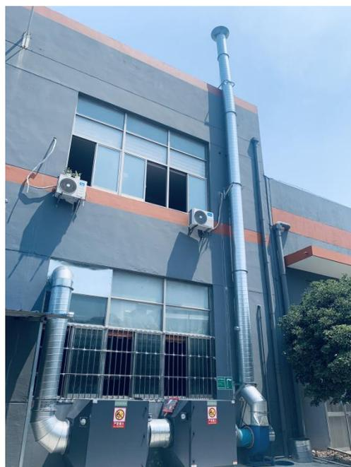
图 4-2 废气治理设施和 P1 排气筒
