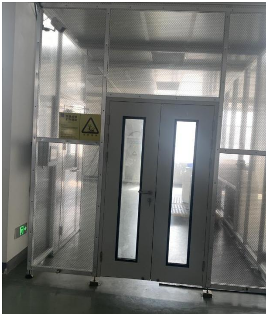
危险废物仓库
